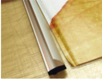
Befestigen Sie die neue Bahn in der oberen Klemmschiene.
